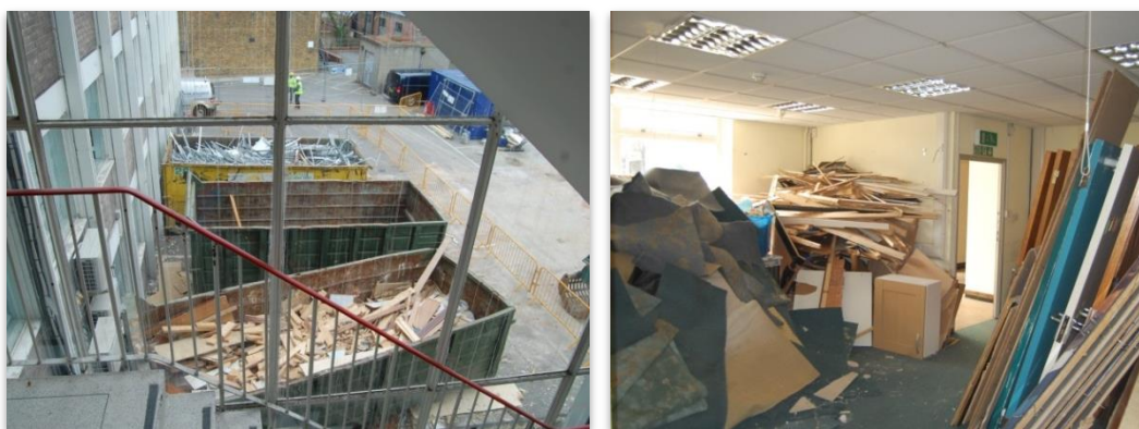
Separación en origen en una obra de demolición. Fuente: UEPPG
