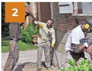
**Perforaciones** realizadas generalmente de 26 mm de diámetro. **Inserción de los tubos** Multipoint en las perforaciones e **Inyección de resina Urettek Geoplus®** en profundidad en el terreno con sistema Multipoint®.
