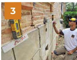
**Monitorización en tiempo real con sistemas láser** para garantizar la seguridad de la intervención. **Criterio de eficacia: "inicio de levantamiento".**
