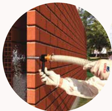
Aislamiento intermedio en fachadas
