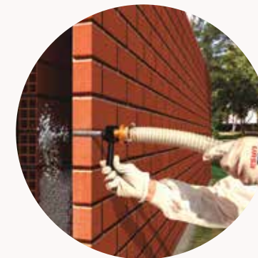
Aislamiento intermedio en fachadas
